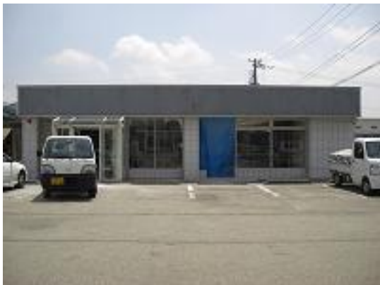
(コンビニ空き店舗)
